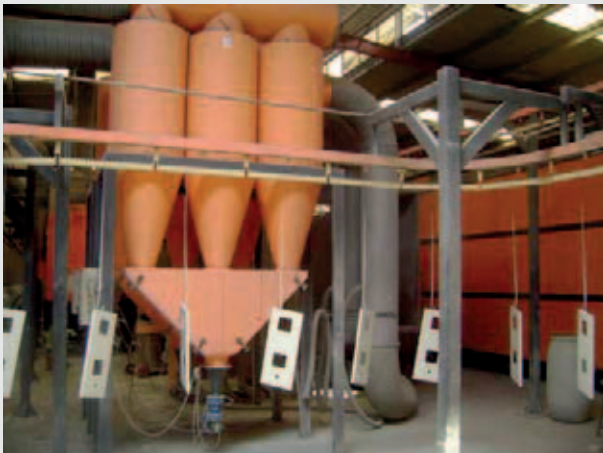
Förderband beim Pulverbeschichtungsprozess (Quelle: Copyright by UNIDO)
