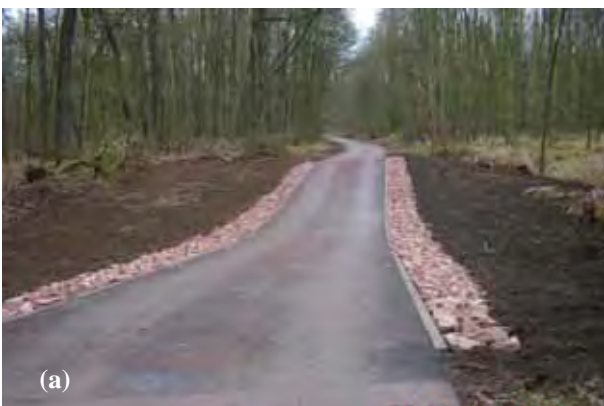
Abb. 4: (a) Absenkung eines Wegedammes in einer Flutrinne (Foto A. Eichhorn). (b) Durchströmung einer Flutrinne mit abgesenktem Wegedamm nach abgelaufenem Hochwasser (Foto U. Patzak).
