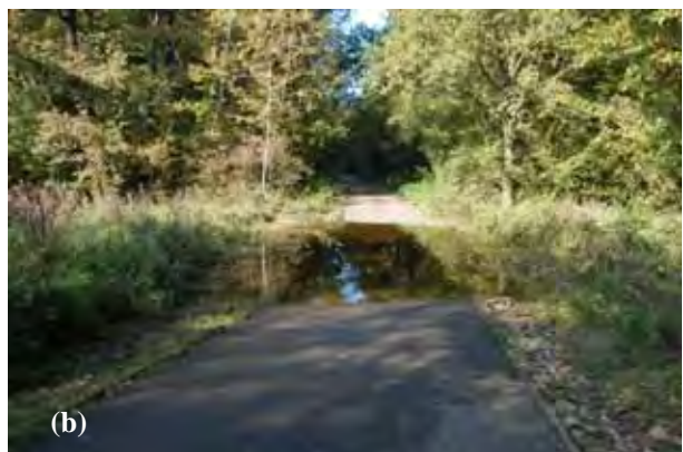
Abb. 4: (a) Absenkung eines Wegedammes in einer Flutrinne (Foto A. Eichhorn). (b) Durchströmung einer Flutrinne mit abgesenktem Wegedamm nach abgelaufenem Hochwasser (Foto U. Patzak).
