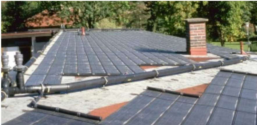
Abb. 15: Beispiel für die Installation von Thermosolkollektoren auf einem Flachdach 8
