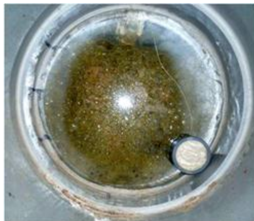
Abbildung 20: Sichtfenster des Biogasreaktors der Anlage „Nawaro 3“ mit Strichen zur Beurteilung der Stärke der Schaum- bzw. Schwimmschichtbildung
