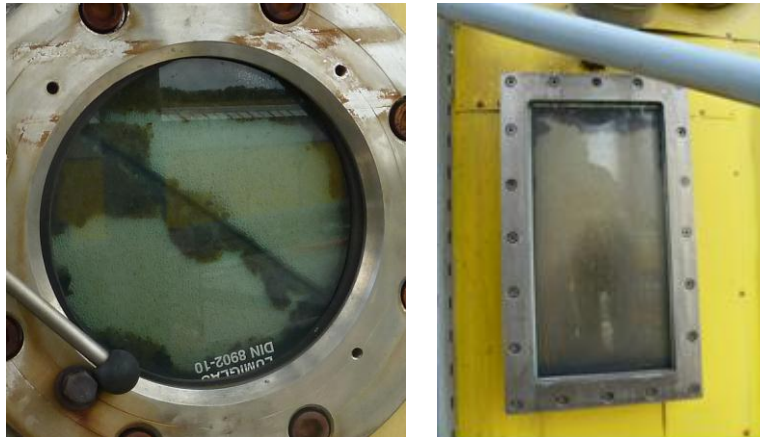
Abbildung 16: Sichtfenster der Biogasanlage „KF-Abfall“ mit kleinblasigem Schaum im Fermenter
