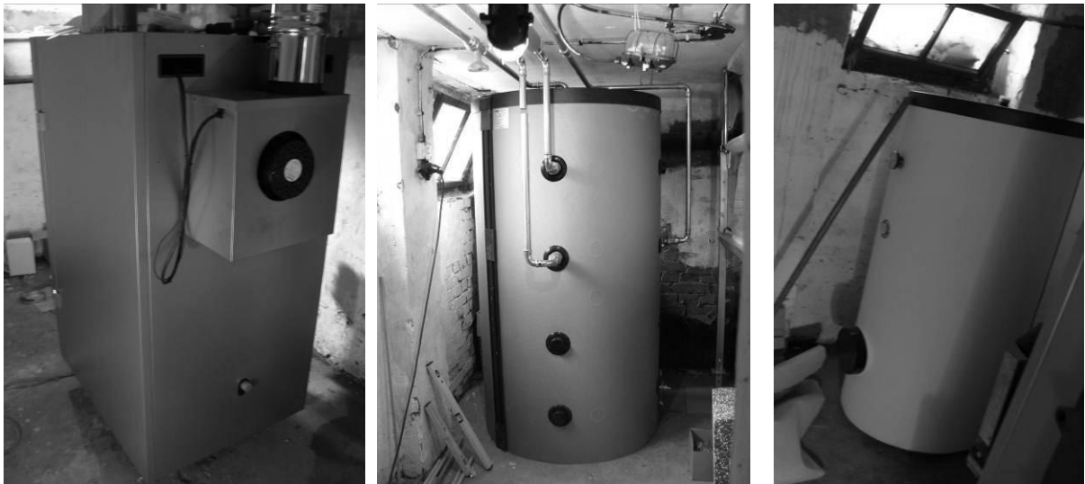
Abb. 5 - 7: 18-KW-Pelletkessel, Pufferspeicher 750 l und Warmwasserspeicher
