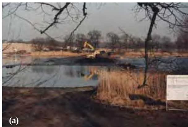
Abb. 5: Sanierung des Kühnauer Sees bei Dessau: (a) Rückbau eines Wegedammes in einem Altwasser, (b) Entschlammung nach Wasserhaltung in einem durch Spundwände abgegrenzten Gewässerabschnitt (Fotos L. Reichhoff).
