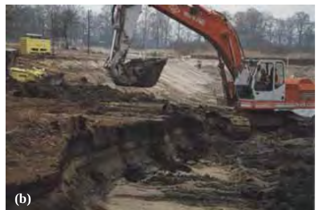
Abb. 5: Sanierung des Kühnauer Sees bei Dessau: (a) Rückbau eines Wegedammes in einem Altwasser, (b) Entschlammung nach Wasserhaltung in einem durch Spundwände abgegrenzten Gewässerabschnitt (Fotos L. Reichhoff).
