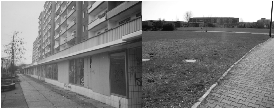
Abb. 3.2.2: Wohnblock „Eiger Nordwand“ an der neuen Leipziger Straße in Grünau Nord vor dem Rückbau 2007 (links) und Wohnfolgebrache nach dem Rückbau 2010 (rechts)
