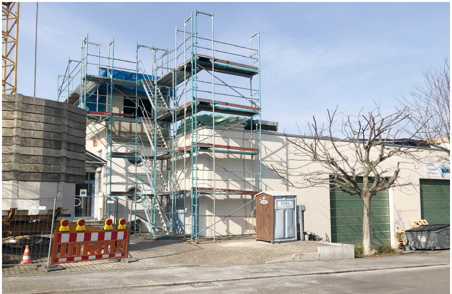
Abbildung 3: Aufstockung Firma Bürkle Haustechnik, Fellbach / Quelle: Dilger
