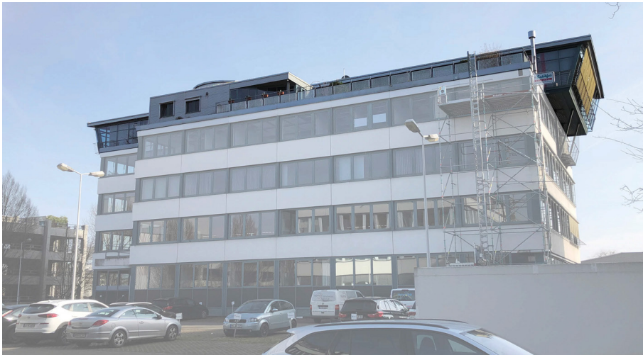
Abbildung 5: Aufstockung Wilhelm-Pfitzer-Straße (Büros Firma Söhnleplan Großküchenplanung), Fellbach / Quelle: Dilger
