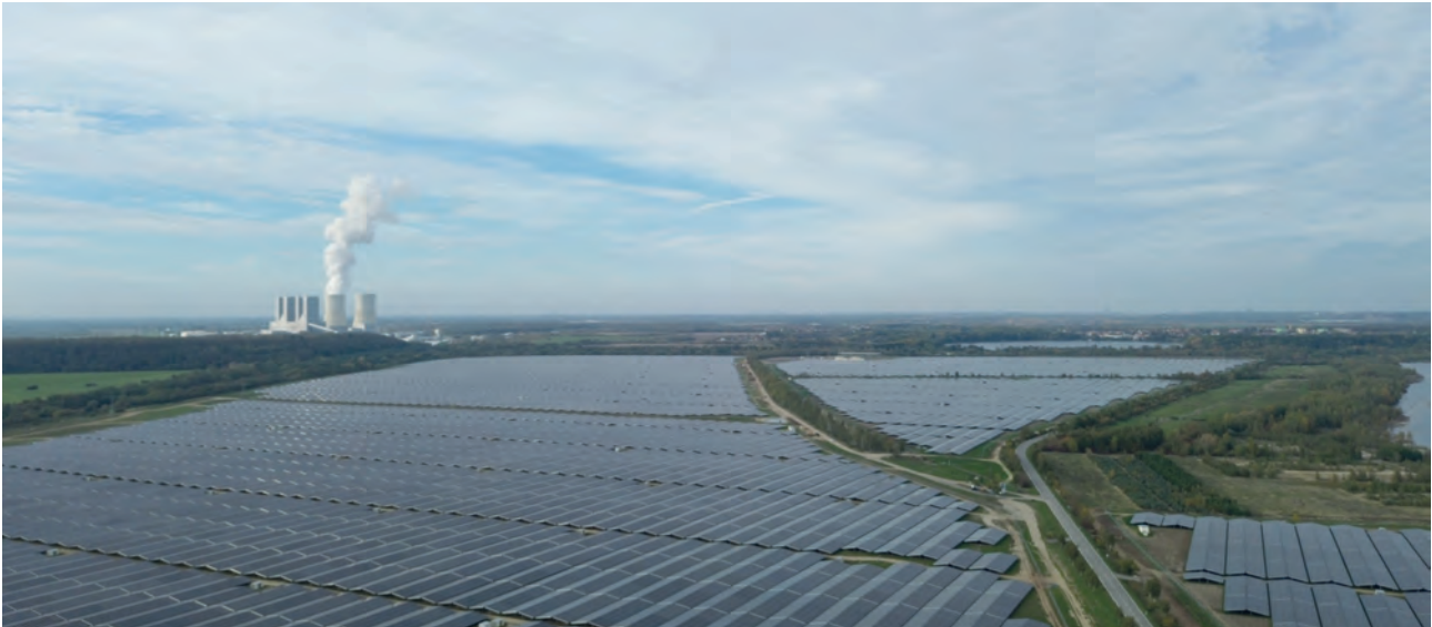
Energiepark Witznitz und Kraftwerk Lippendorf im Oktober 2024
