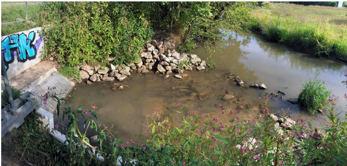
Abbildung 5: Neu gebautes Einlaufbauwerk an der Bega in Lemgo, Situation bei Niedrigwasser
