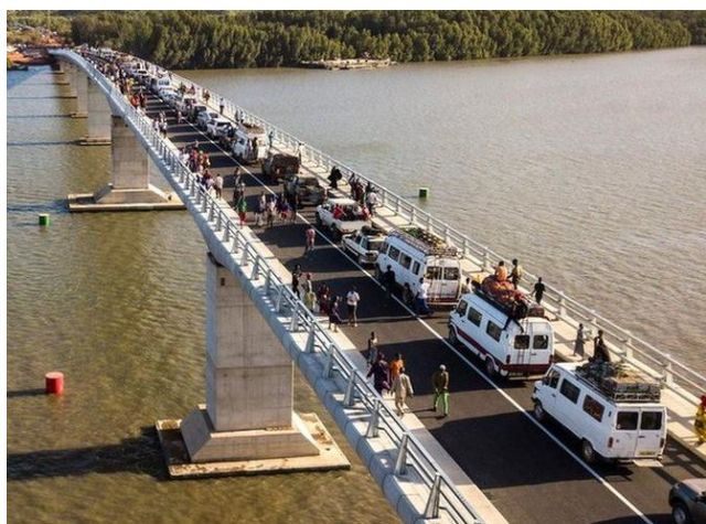
Abb. 5: Senegambia-Brücke als gemeinsames Infrastrukturprojekt (WALLY 2019)
