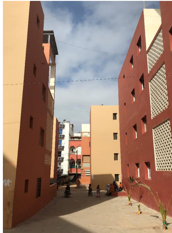
Abb. 4: Wohnkomplex in New Baraka (EIGENE AUFNAHME)
