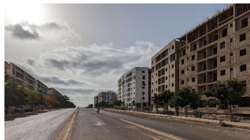
Abb. 7: Straße mit Wohnhäusern in Diamniadio (EIGENE AUFNAHME)
