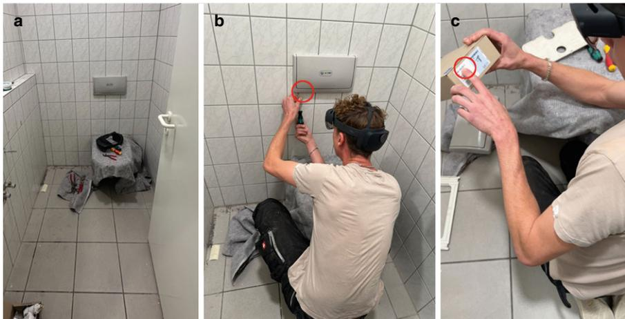
**Abb. 1** a Die Ausgangssituation der durchzuführenden Arbeit Wechsel eines Seitenfüllventils. b Der Mitarbeitende führt unter Anleitung die Tätigkeit aus; der Meister navigiert mit virtuellen Elementen (roter Kreis). c Der Mitarbeitende überprüft die vom Meister gewünschten Informationen
