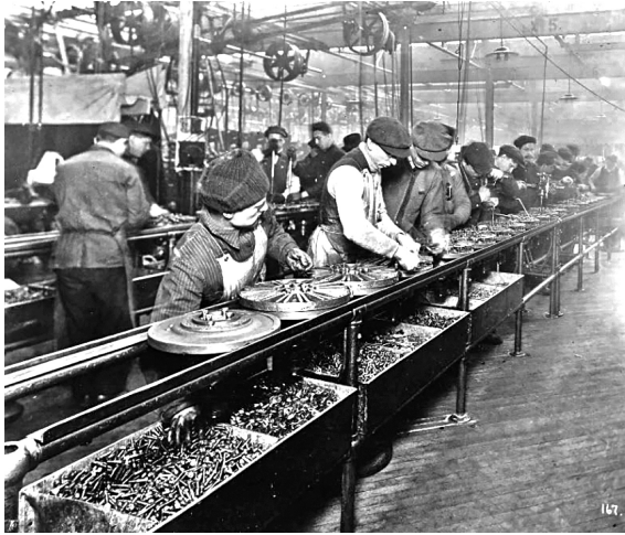
Abbildung 9: „Flywheel Magneto“-Montagelinie, Highland Park (1913)
