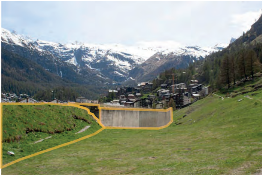
Abb. 6: Der Bahnhof Zermatt und das Gleisbett liegen geschützt hinter einer starken Betonwand und weiteren Aufschüttungen / Quelle: Eigene Abbildung
