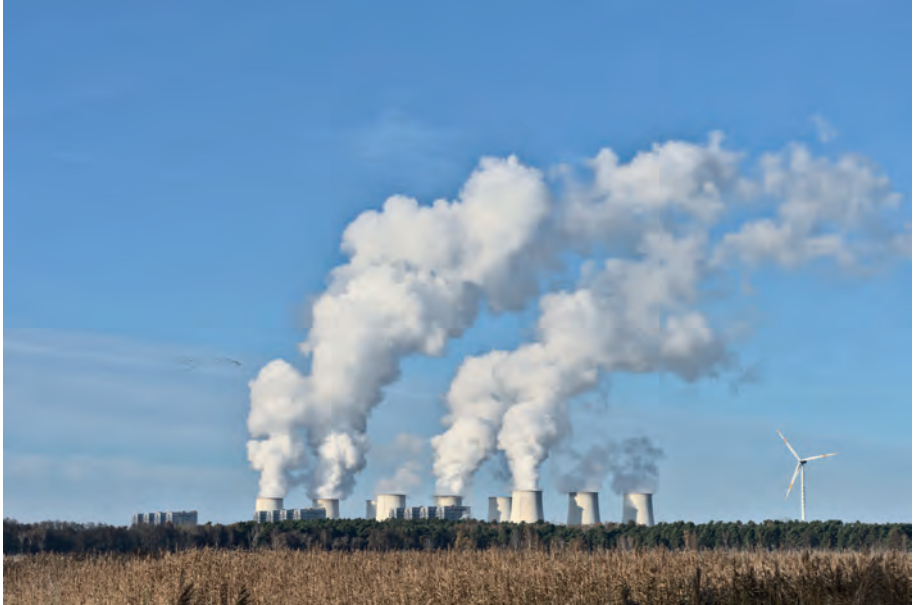
Abb. 5: Strukturwandel im Lausitzer Revier (Kraftwerk Jänschwalde) / Quelle: Juliane Ribbeck-Lampel 2022
