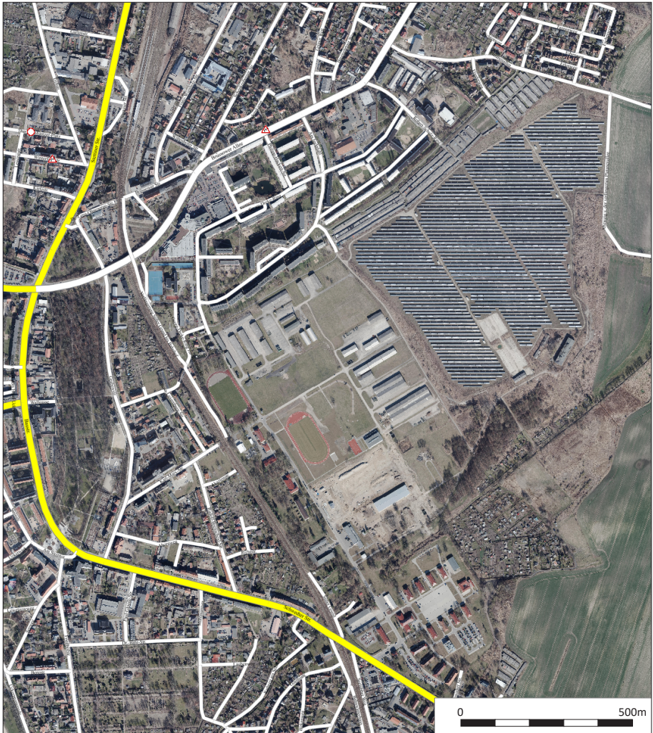
Abb. 2: Die PVA auf dem Gelände des ehemaligen Fliegerhorstes in Prenzlau /Quelle: Stadt Prenzlau
