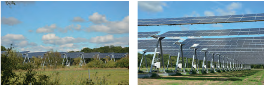
Abb. 3: Beispiel für eine Agri-Photovoltaikanlage, hier Lüchow, Niedersachsen / Quelle: Petra Schneider
