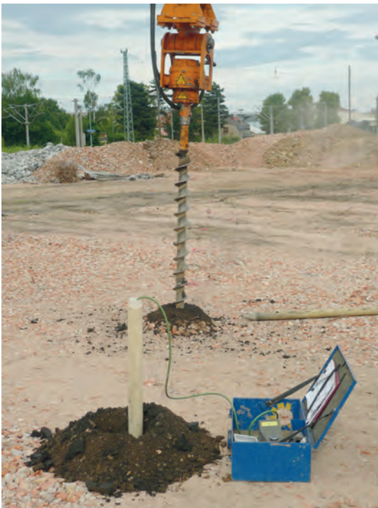
Abb. 2: Kampfmittelsondierung auf einer ehemaligen Industriebrache / Quelle: Petra Schneider
