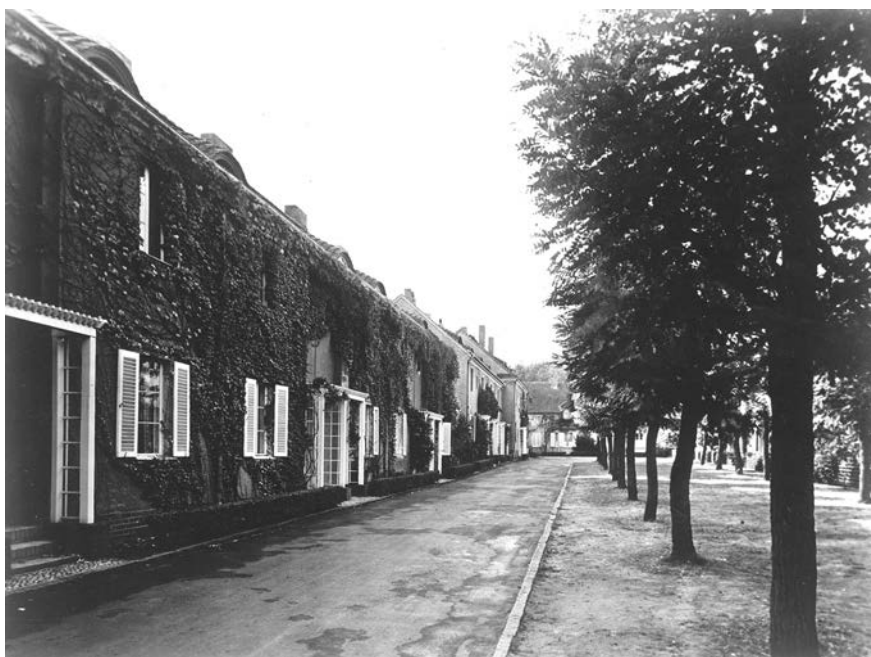
Bild 5.5: Gartenstadt Falkenberg, Reihenhäuser im Akazienhof, gebaut 1913-1916, Architekt Bruno, Foto: unbekannt (nach 1920)
