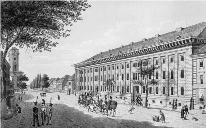
Bild 3.1: Lehr-Escadron-Kaserne, erbaut 1818, Architekt Karl Friedrich Schinkel, kolorierte Radierung um 1825 © Bildarchiv Foto Marburg
