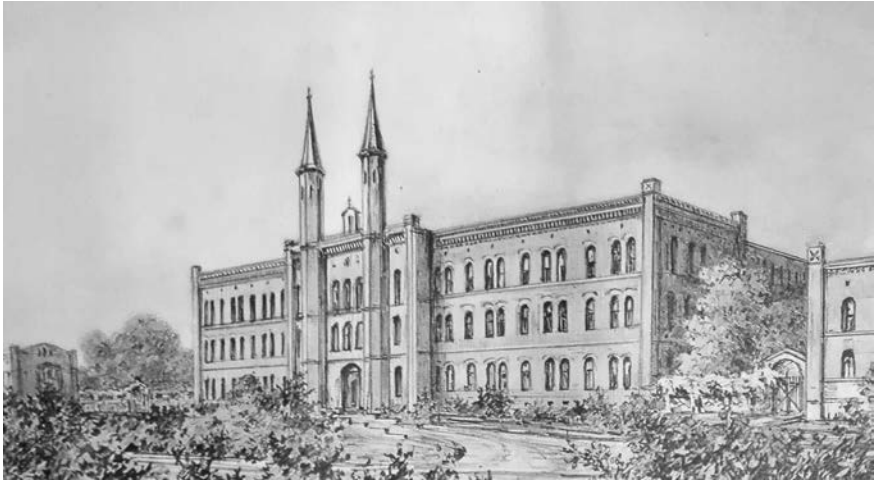
Bild 3.23: Diakonissen-Krankenhaus Bethanien, Berlin-Luisenstadt (heute Kreuzberg), erbaut 1847, Architekten: Friedrich-Wilhelm IV., Ludwig Persius, Friedrich August Stüler, Theodor August Stein, Stich um 1850
