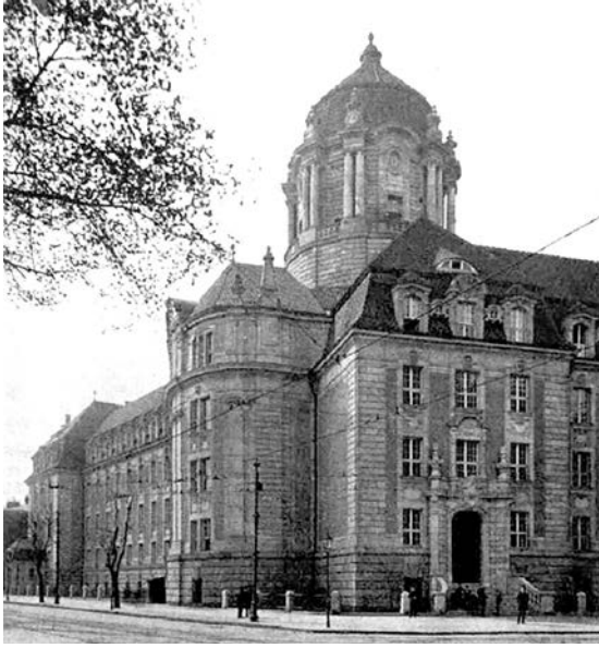
Bild 3.54: Das Neue Kriminalgericht Berlin-Moabit, erbaut 1906-1908, Architekten Carl Vohl und Rudolf Mönlich, Foto: 1908
