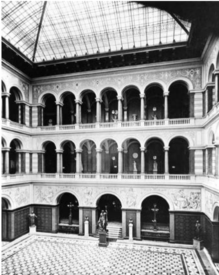
Bild 4.26: Königliche Technische Hochschule Charlottenburg, Hauptgebäude Ehrenhof, Architekt: Friedrich Hitzig, Foto: 1884
