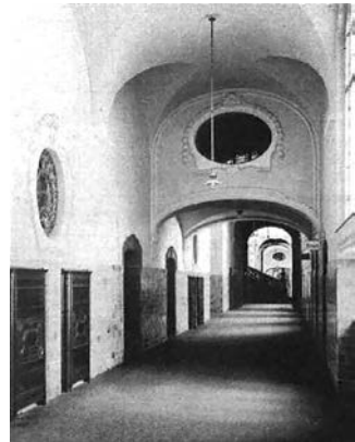
Bild 3.56: Das Neue Kriminalgericht Berlin-Moabit, „Flur im Erdgeschoß des Saalbaues mit brückenartigem Einbau für die Gefangenenzuführung“, erbaut 1906-1908, Architekten Carl Vohl und Rudolf Mönlich, Foto: 1908
