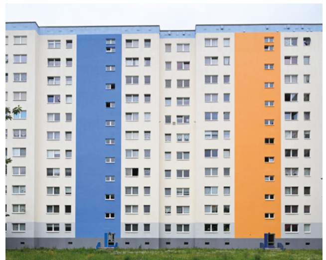
Abbildung 25: Im Kosmosviertel ist die Wohnraumversorgung von einfachen bis mittleren Wohnstandards geprägt (Foto: vhw e. V.)
