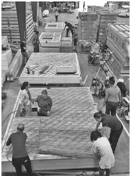
Abb. 2: Vorproduktion von Außenwand-Elementen im Vivihouse -Bauworkshop. Foto: Vivihouse , CC BY-SA.
