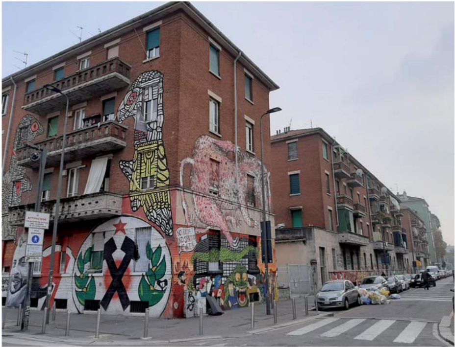
Fig. 2 - Esempi di edilizia pubblica residenziale in zone cittadine pericentrali (via Gola-via Pichi, Navigli) interessata da occupazioni, illegalità e degrado
