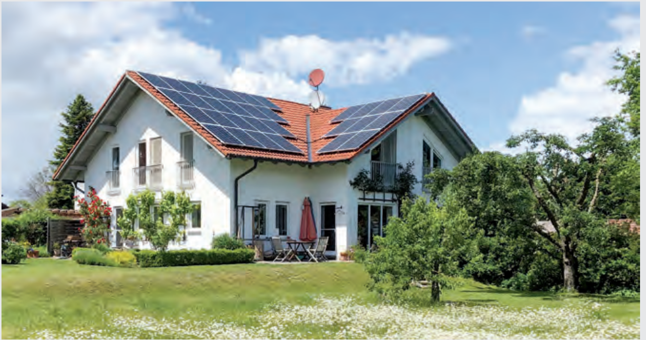
Abbildung 44: Stromerzeugung mit Photovoltaik auf den Hausdächern der Mitarbeiter*innen (Quelle: Develey Senf & Feinkost GmbH)
