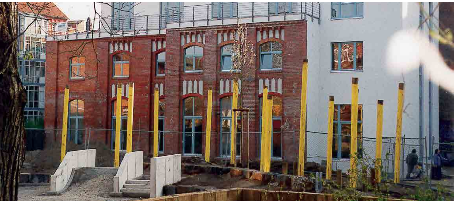
Im alten Maschinenhaus auf dem ehemaligen Sprengelgelände hat die WOGÉ ein Kinderhaus und Wohnungen für Jugendliche geschaffen. (Foto: WOGÉ Nordstadt eG)
