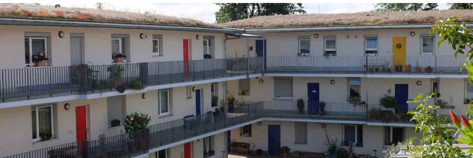
Ansicht der hofseitigen Laubengänge des Wohnprojekts
