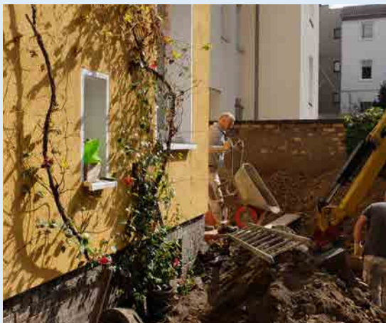
Sanierung der Rohrleitungen, Gartenseite der Merseburger Straße 17
