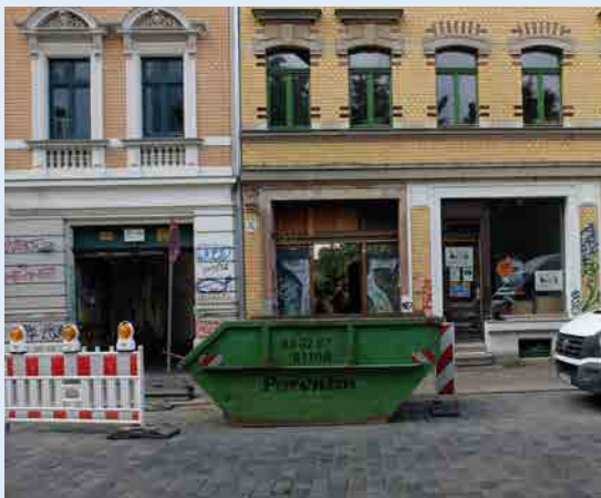
Straßenansicht, seit 2020 wird die Merseburger Straße 17 wieder saniert.
