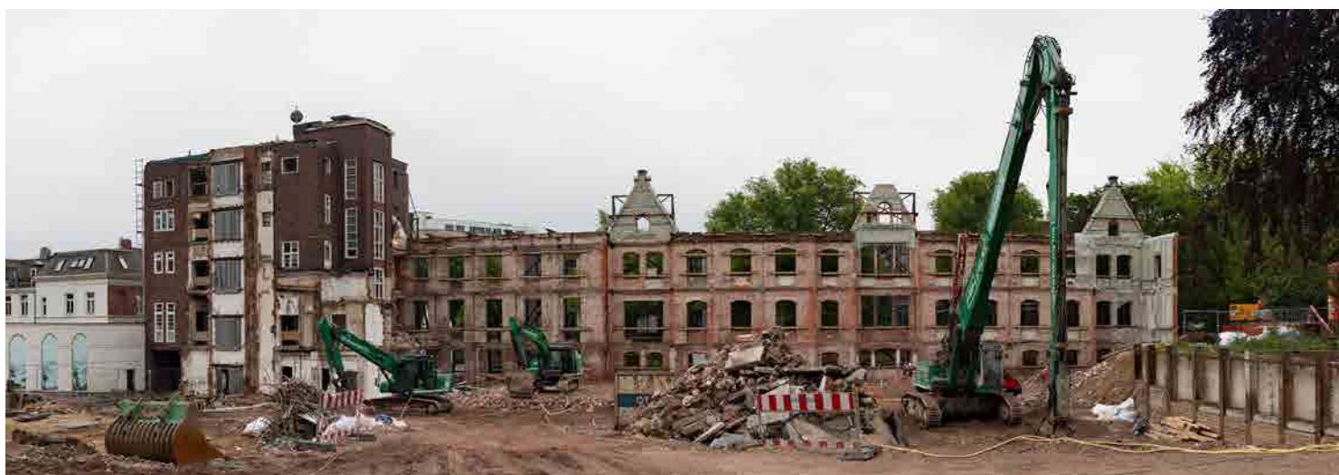
Im Bau: Rückseite der alten Klinikfassade. (Foto: kunstklinik.hamburg)
