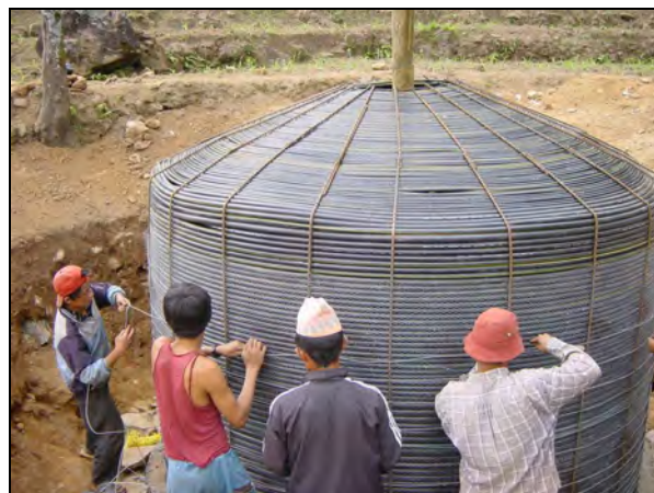
Abb. 52: Bau des Reservoirtanks in Pelumba, 2007
