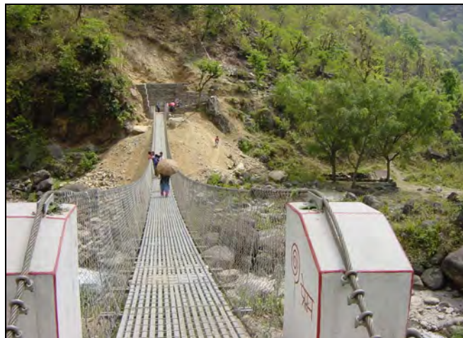
Abb. 46: Neue Brücke in Chepchewa, 2008
