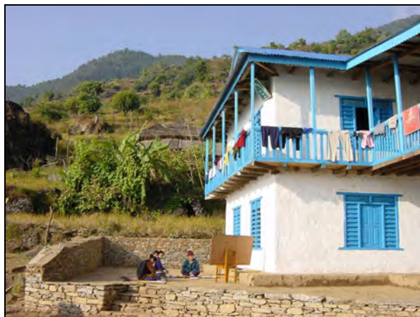
Abb. 48: Gemeinschaftsgebäude in Pelumba, 2003
