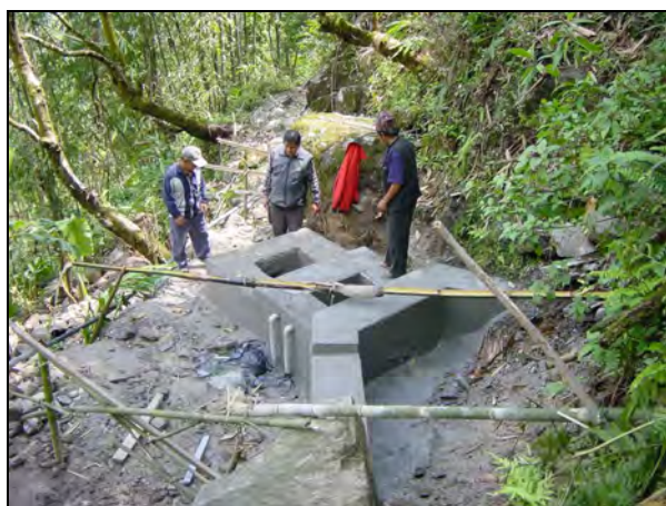
Abb. 53: Bau der Quellfassung in Pelumba, 2007
