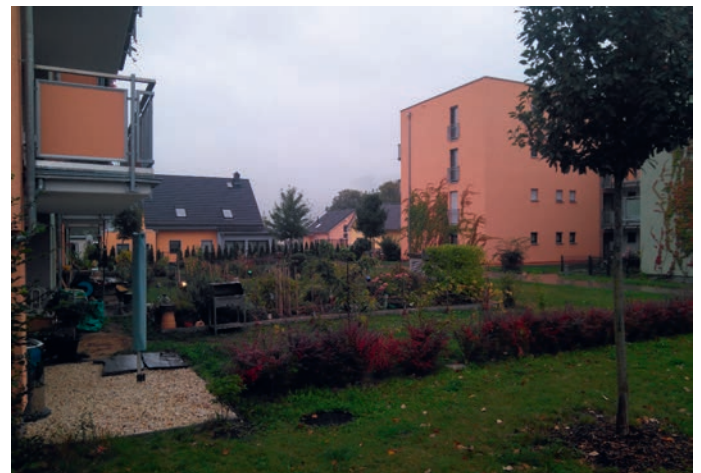
Abb. 10: Aktuelle Bebauung auf dem Gelände des Projektes Zwätzen Nord, Fotos: Quaestio 9/2019
