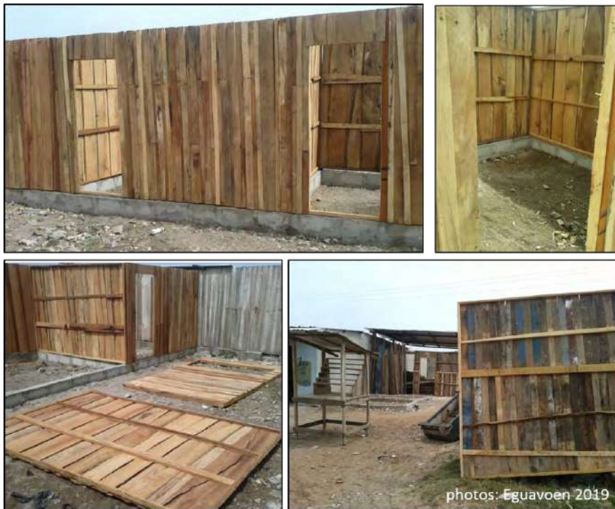
Image 15 Panneaux préfabriqués en bois au marché d'Adjahui-Coubé
