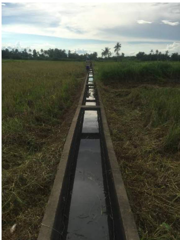
Figure 1B- 19. Main canal of Sta. Elena CIS
