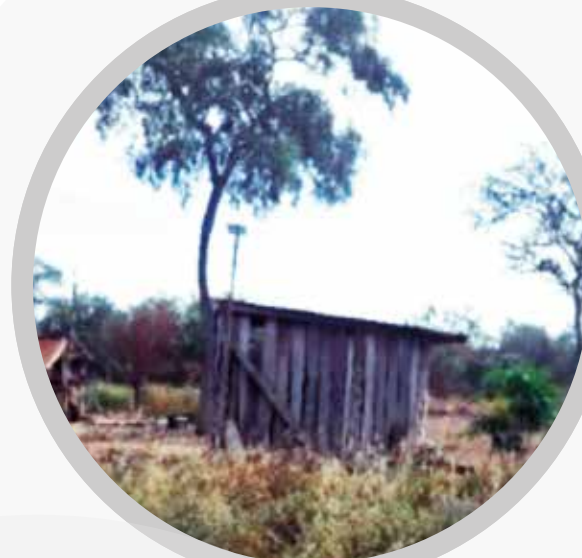
Panel A: Prototipo de vivienda donde se instaló el Panel Solar
