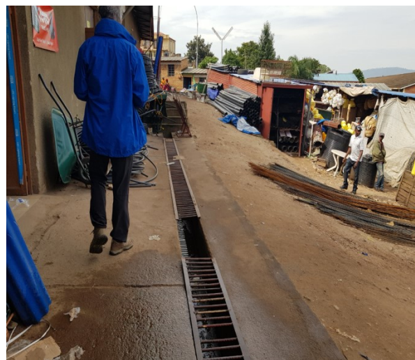
Abb. 8: Westseite des Marktes mit Abwasserkanal (HELBIG 2020)
