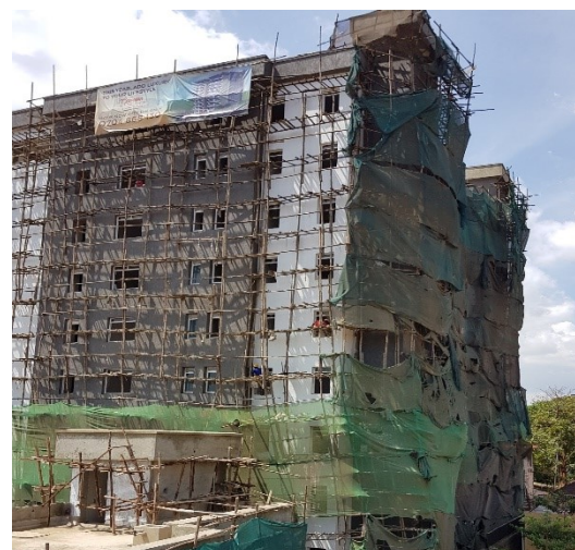
Abb. 3: Eukalyptus als Material für Baugerüste (HÜNEMOHR 2020)
