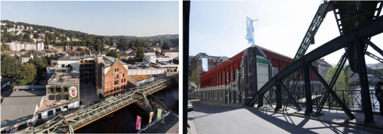
Abbildung 15: Das ELBA-Gelände in Wuppertal
