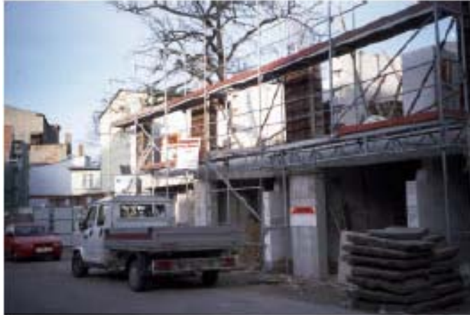
Abbildung 23 Neubau von Einfamilienhäusern im historischen Stadtkern von Stralsund
