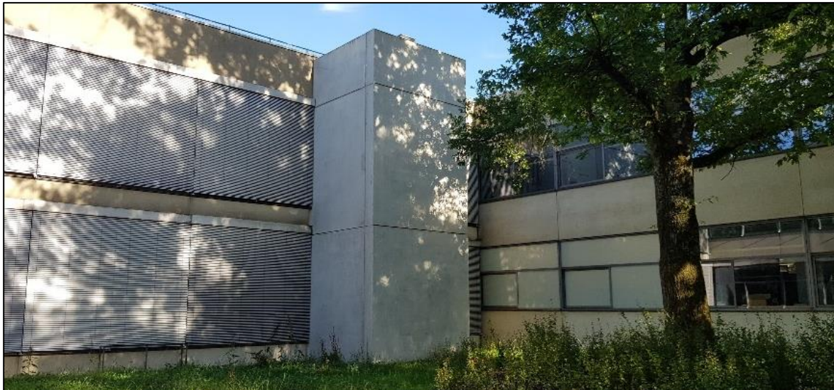
Abbildung 43: Nachträglich gebauter Aufzug eines denkmalgeschützten Hochschulgebäudes
