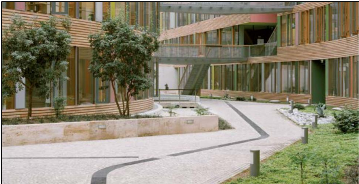
Abbildung 47: Beispiel eines taktilen Leitsystems im Außenbereich Quelle: Bredt 2016
