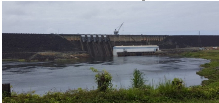
Abb. 11: Wasserkraftwerk Afobaka mit Staumauer (SAUERHAMMER 2019)
