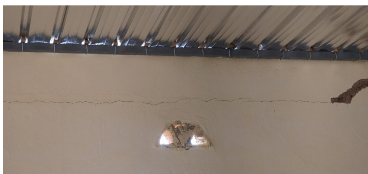
Fissures dans le mur d'une maison récemment construite pour la réinstallation des habitant-e-s dans le nouveau village de Bouly (Photo: Merle Groneweg, 2017)
