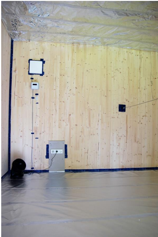
Abbildung 12: Innenansicht des Haustyps 1
