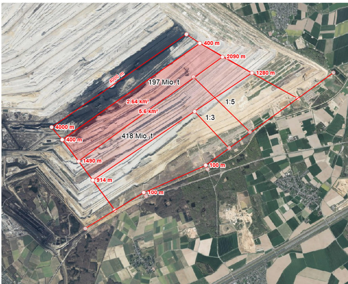
Abbildung 9: Tagebau Hambach, Gewinnungsböschung 1:3 und 1:5, Tagebaukante Stand 09/2019
