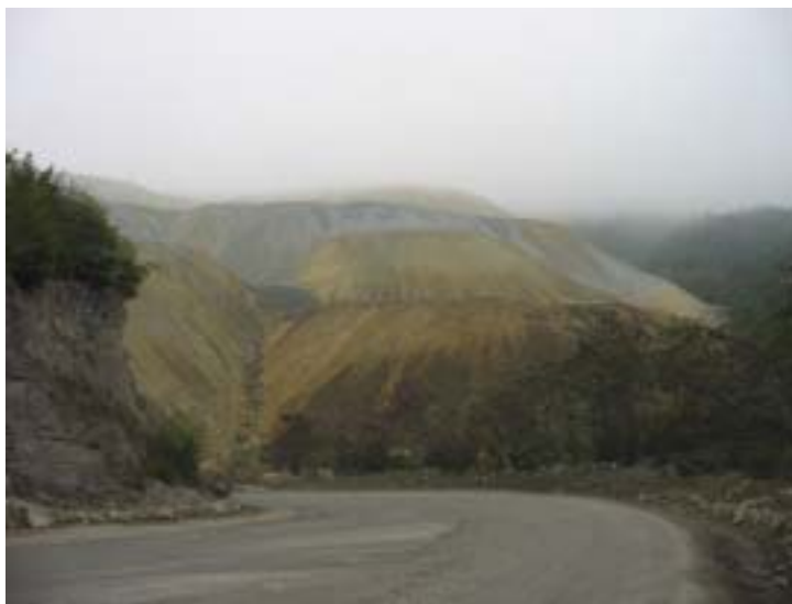
Abb. 8: Unsachgemäß angelegte Abraumhalden mit Erosionsrinnen.
