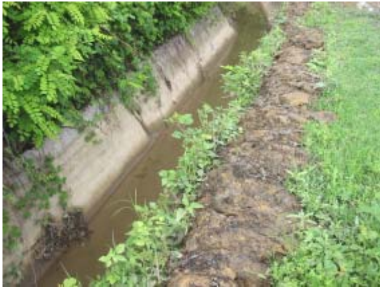
Abb. 17: Ausgehobene Sedi- mentschlämme am Rande des Kanals.
