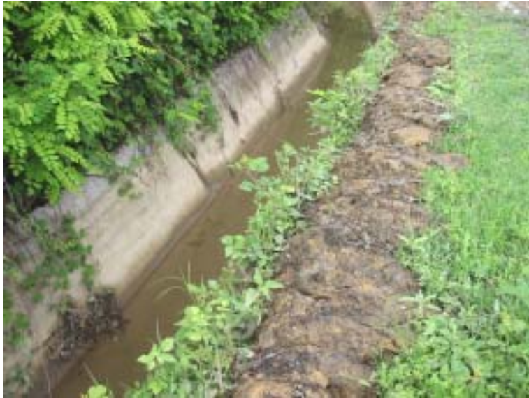
Abb. 17: Ausgehobene Sedimentschlämme am Rande des Kanals.
