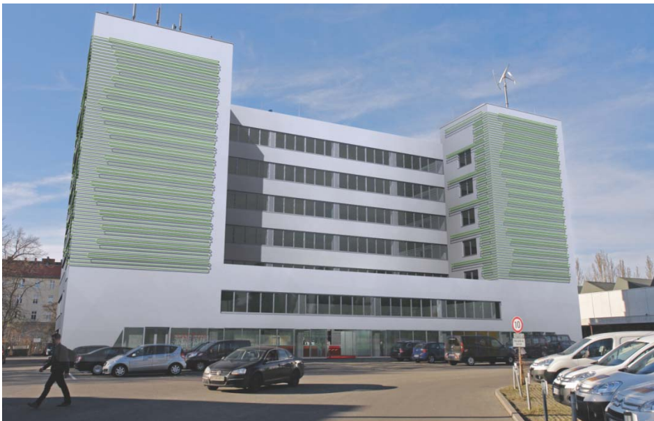
Abb. 24 Das Bild zeigt die geplante Fassade eines Berliner Bürogebäudes auf dem EUREF-Campus mit Algen-Bioreaktoren; [GF]
