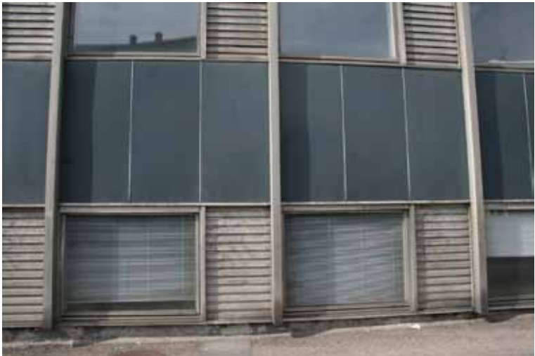
Billede 7: Facaden af Valby-domicilet
