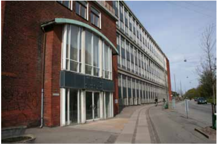
Billede 6: Facaden af Valby-domicilet
