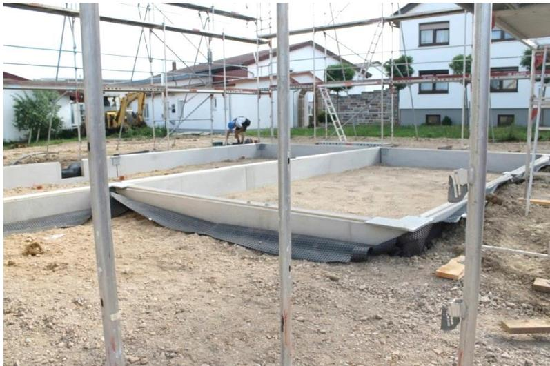
Abb. 18: Erstellung der Fundamente<sup>332</sup>
