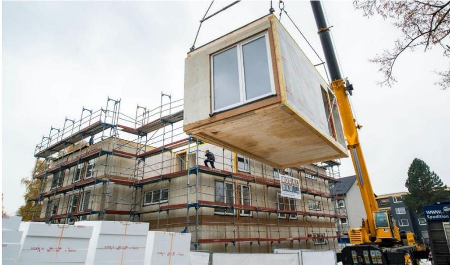
Abb. 15: Errichtung eines modularen Gebäudes<sup>271</sup>
