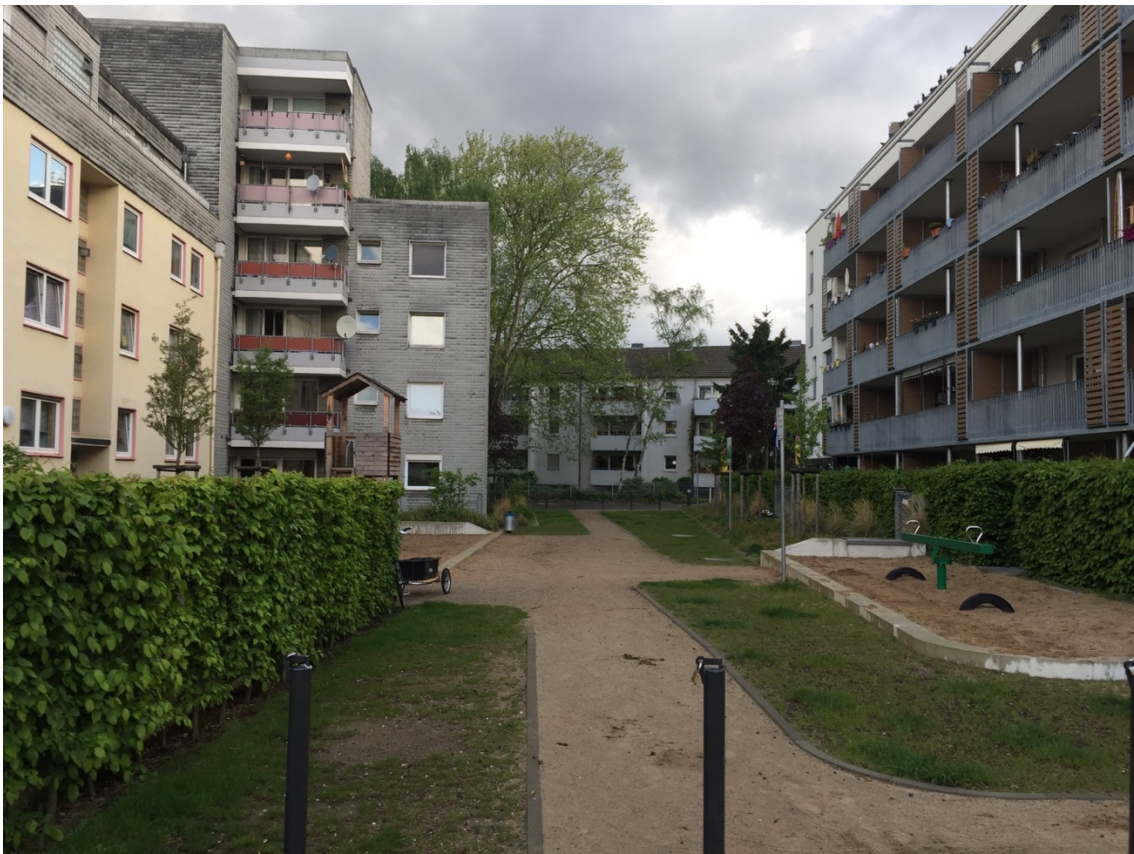
Abbildung 13: Links der Bestand, rechts im Bild der Neubau mit BHKW.
