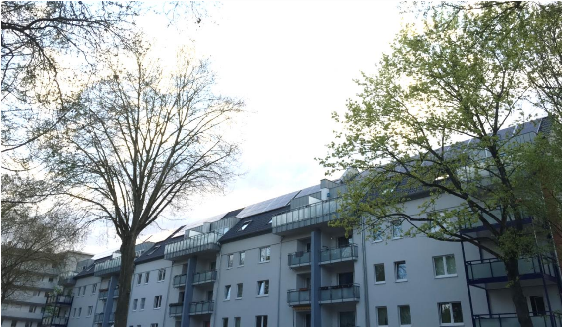
Abbildung 19: Durch die großzügige Struktur der Stegerwaldsiedlung sind auch die PV-Anlagen gut einsehbar.
