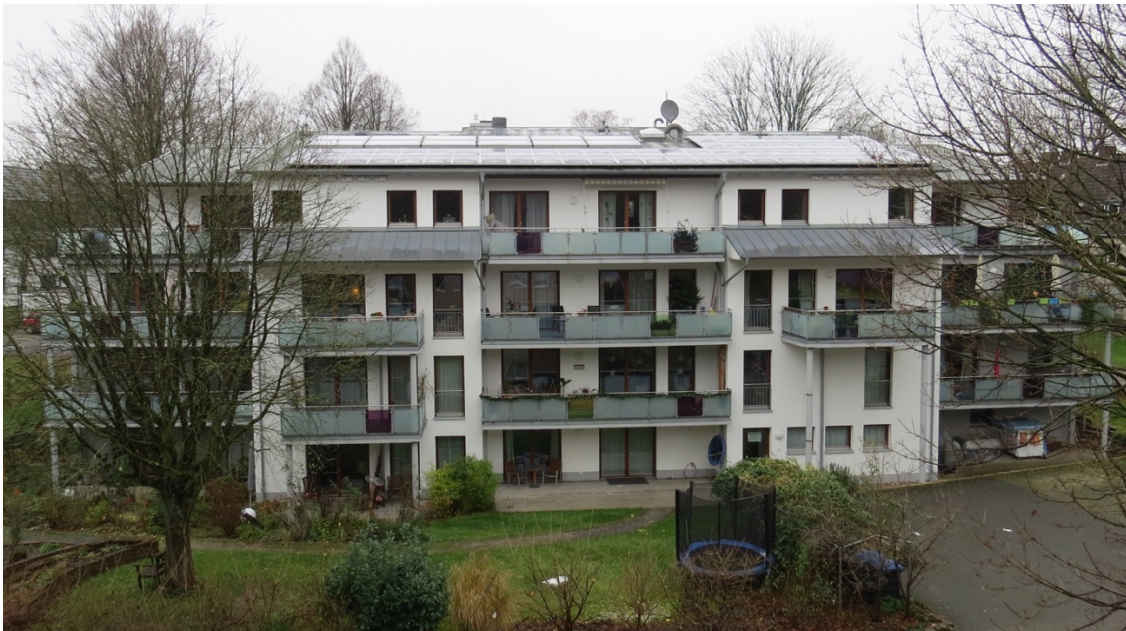
Abbildung 22: Vom Südring aus ist die PV-Anlage auf dem Dach des Wohnhauses gut sichtbar.
