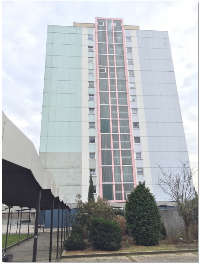
Abbildung 16: Seitenansicht auf die Original-Fassade aus den 70ern.
