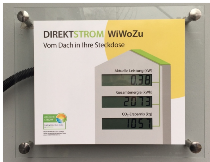
Abbildung 23: Über die digitale Anzeige im Eingangsbereich ist die Leistung der Anlage für alle gut sichtbar.
