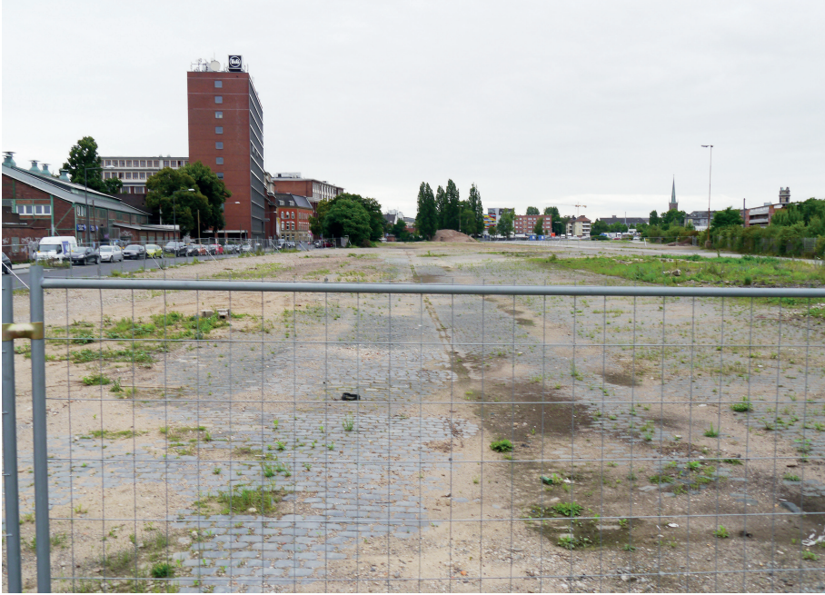
Abb. 10: Illustration des Plangebiets – die Brachfläche / Quelle: Üblacker
