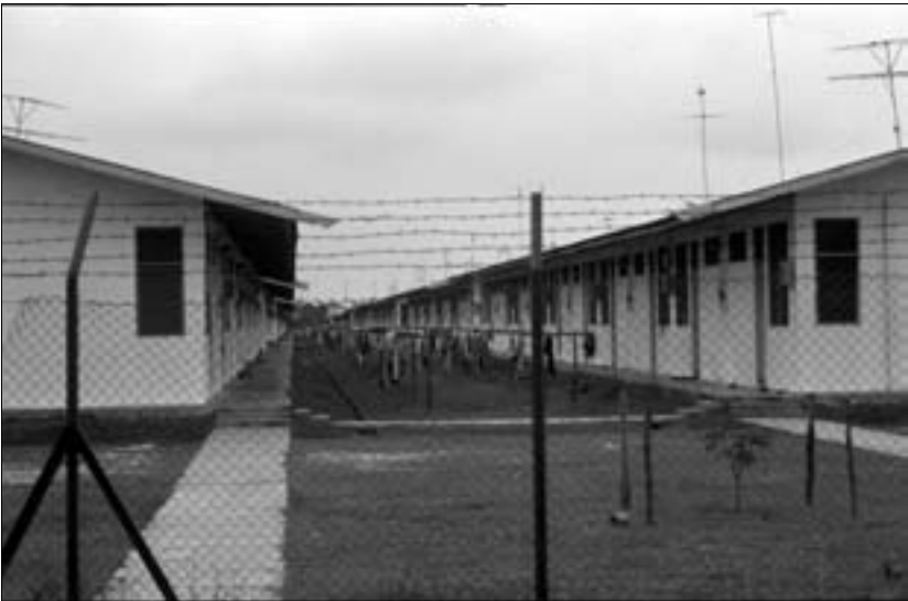
Abb. 4: Wohnunterkünfte der zumeist weiblichen Arbeitskräfte im Batamindo Industrial Park
