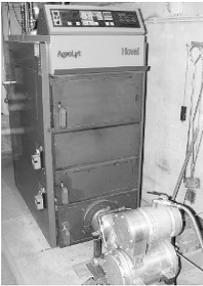
Dieser Scheitholzkessel mit Stirlingmotor mit 1 kW Stirlingmotor läuft z. Zt. im Feldversuch u. a. in Sulzbach/Saarland.
