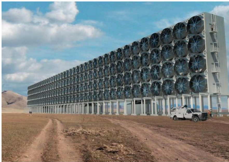
Abb. 4-5 Carbon Engineering Konzeptentwurf (geplante Abscheideleistung 1 Mt CO 2 /a)
