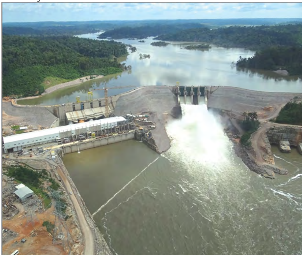
FIGURA 7 Barragem da UHE Teles Pires
