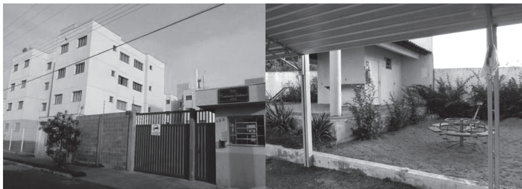
FIGURA 14 Portaria de acesso e área de lazer do Residencial Baltimore
