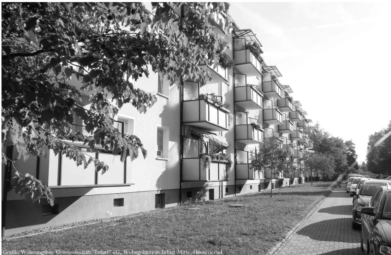
Grafik: Wohnungsbau-Genossenschaft "Erfurt" eG, Wohngebiete in Erfurt-Mitte, Hanseviertel
