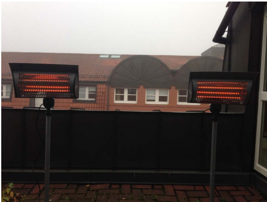
Abbildung 72: Foto der Terrassenheizungen
