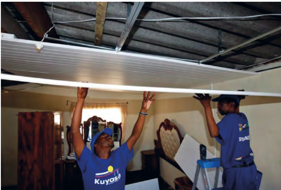
Foto 12: Montage der Deckenisolation, Quelle: Walsh et al. 2011: 22
