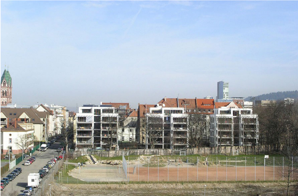
Abb. 22: Spiegelhäuser der Baugruppen in der Klarastraße, Stadtteil Stühlinger (2006, Amann Burdinski Munkel Preßer Architekten , Freiburg)
