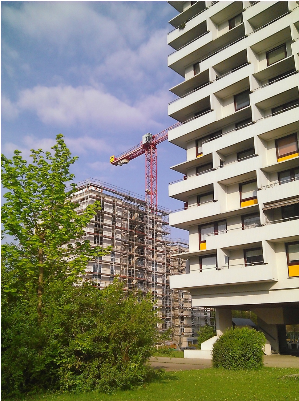
Abb. 8: Ersatzwohnungsbau in der Düsseldorfer Straße in Stuttgart-Hallschlag 2010
